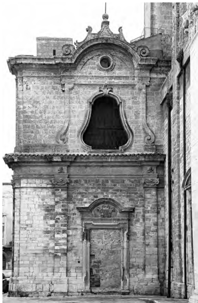
4. Gioia del Colle (BA), Cappella del Purgatorio, facciata.
