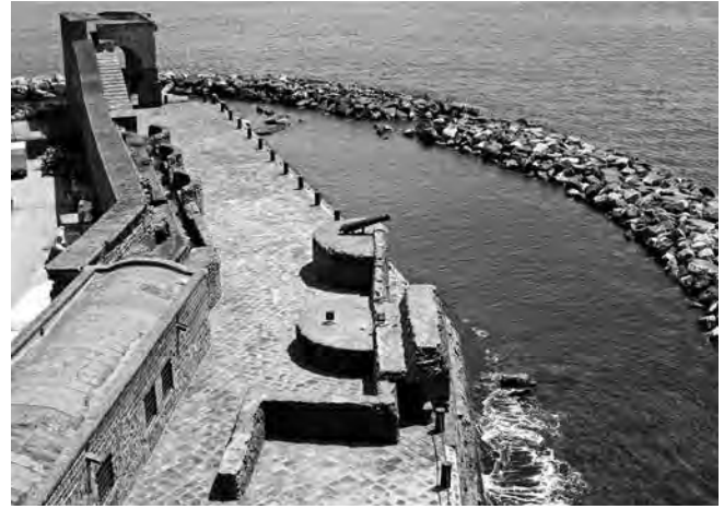
9. Napoli, Castel dell'Ovo, Batteria e molo del Ramaglietto.
